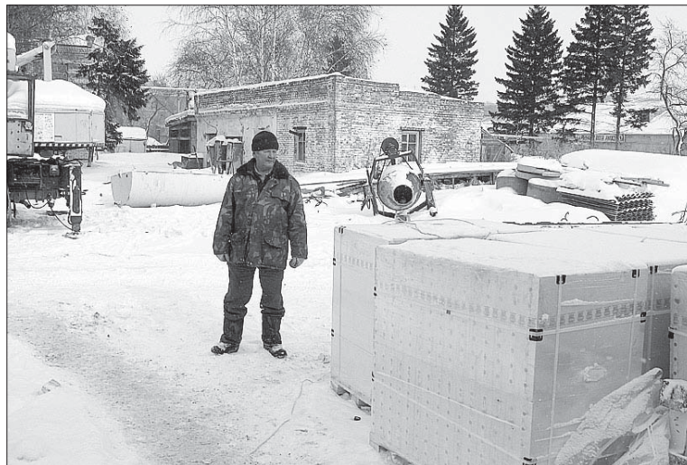
Строительные материалы для молцеха полностью завезены.
